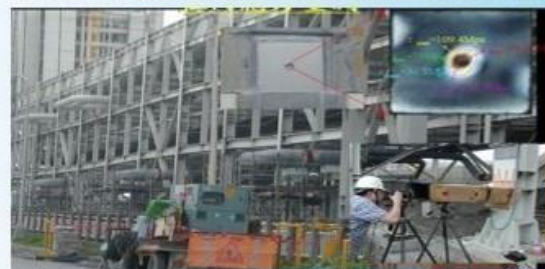
六輕鋼架什構磁鉛應力檢測
