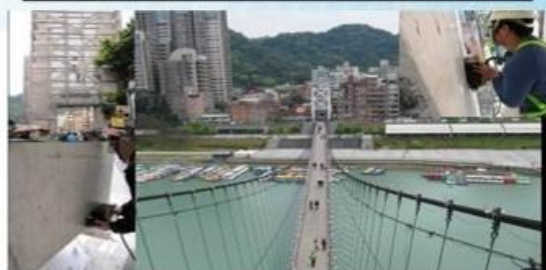
碧潭吊橋結構安全與評估
