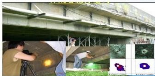
台北預力橋梁磁鉛應力檢測
