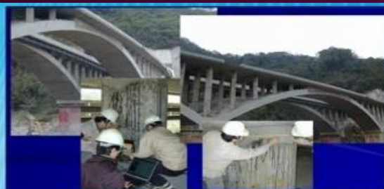
苗栗拱橋橋梁結構損傷檢測
