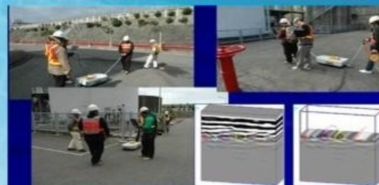
墾丁消防地下管線定位檢測
