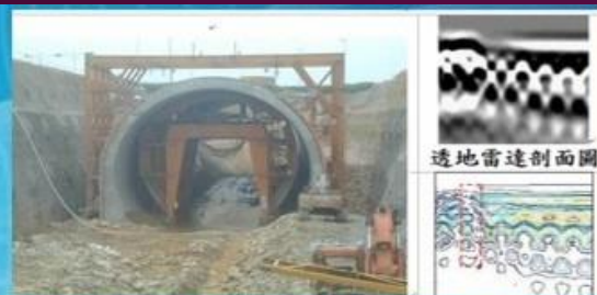
高鐵隧道結構冷縫界面檢測
