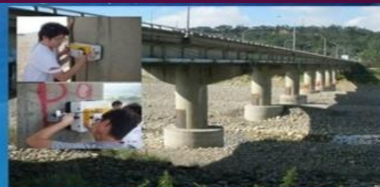
北部(59座)橋墩鋼筋尺寸檢測
