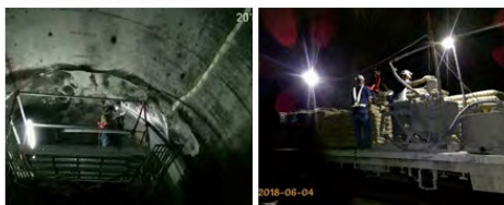
隧道襯砌背填加固
