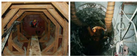
豎井側壁注漿
