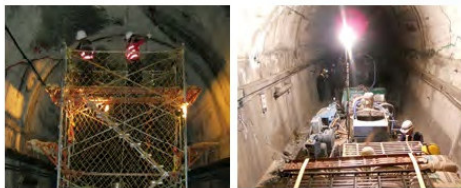
隧道襯砌結構補強
