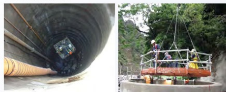
TBM 隧道湧水
