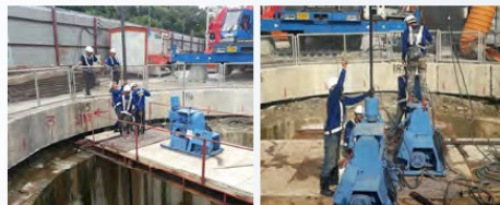
豎井封底注漿
