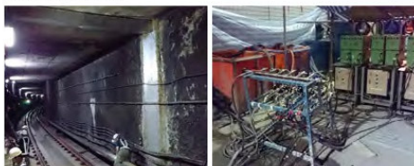
捷運隧道止漏
