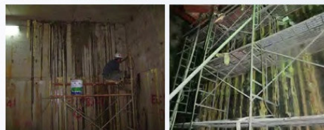
捷運隧道及站體加固
