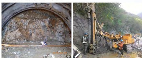
隧道口崩積岩層加固
